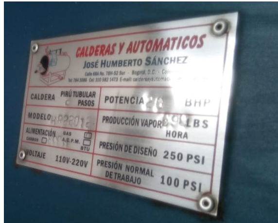
Fotografía No. 4 Placa de la caldera de 20 BHP
